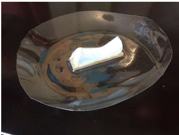
On dégage soigneusement au cutter...
